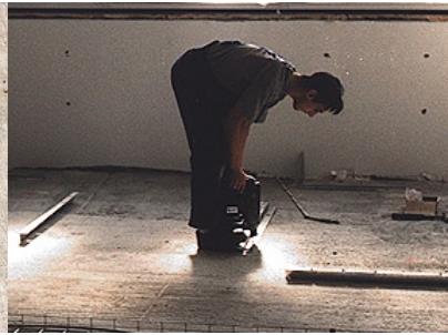
einbau entlang fluchtlinie
