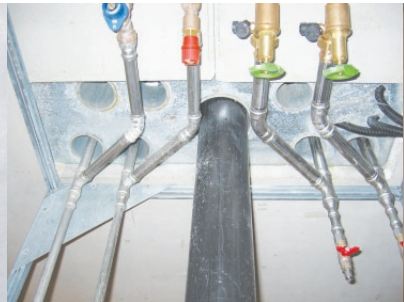
installation und ausführung brandschutz
