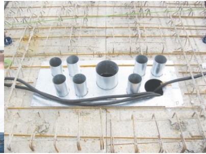
einbau auf filigrandecke
