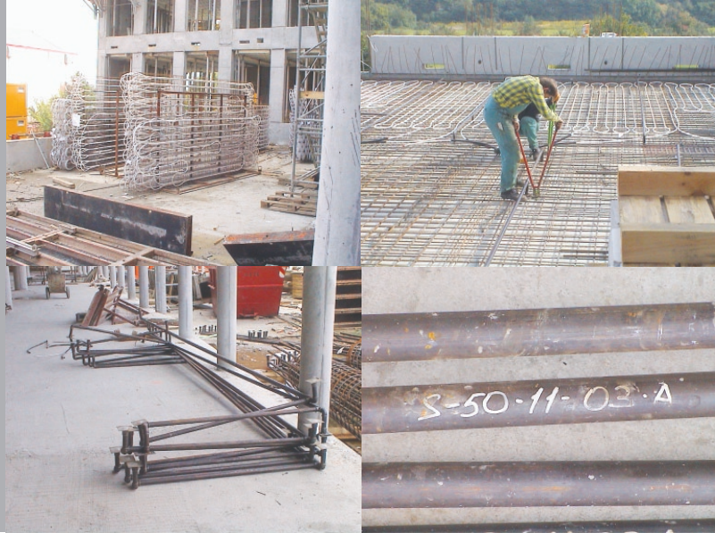
industrielle vortfertigung betonkerntemperatur und sprinkler
